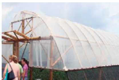
Imagem externa de estufa com estrutura em bambu, modelo CPRA.
