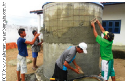
Construção 2º dia.
