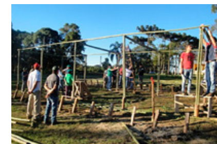
Oficina de construção da Estufa Ecológica.
