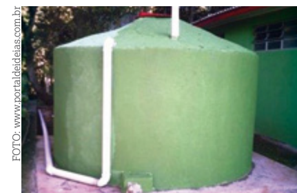
Cisterna de Ferrocimento.
