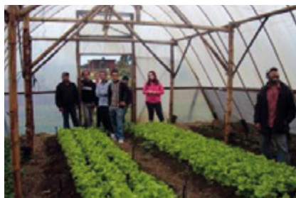
Imagem interna de estufa com estrutura em bambu, modelo CPRA.
