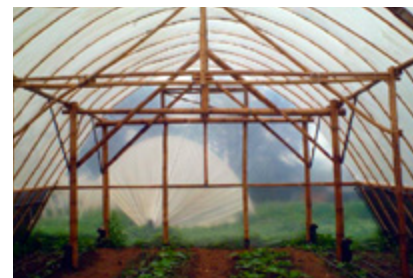
Outra imagem interna de estufa com estrutura em bambu, modelo CPRA.
