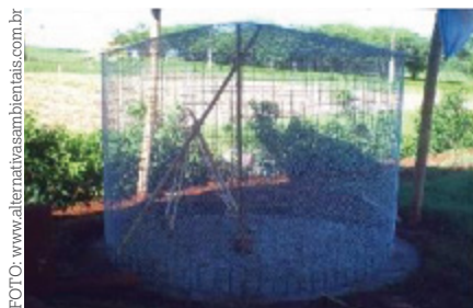
Construção 1º dia (Vitrine de Agroecologia – Parque Tecnológico Coopavel).
